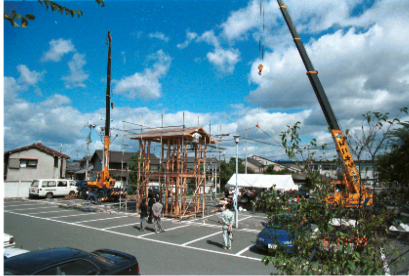
写真6 H棟載荷状況
