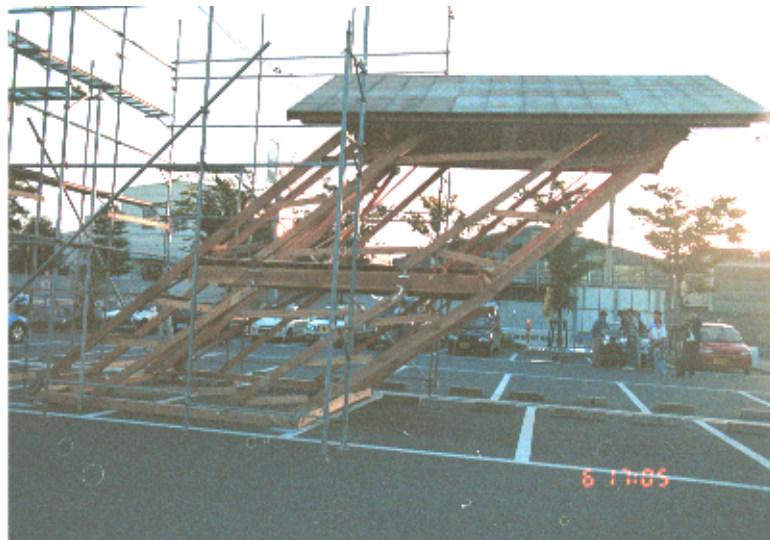
写真 11 H 棟：倒壊する様子
