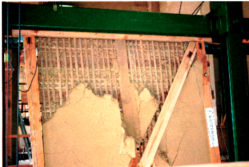
写真 21 試験体 No.7b: 裏面でも壁土が大きく剥落する
