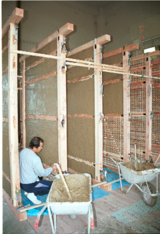
写真 14 荒壁を付けているところ (1997年10月27日)
