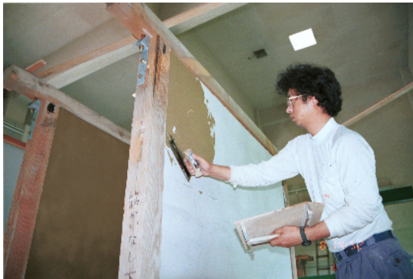
写真 23 上塗り作業の状況
