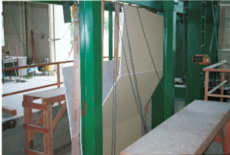
写真 28 試験体 No.1b: ボードが脱落
