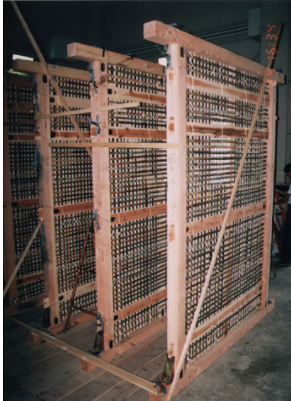
写真 13 下地竹の搔き付けが完了した試験体
