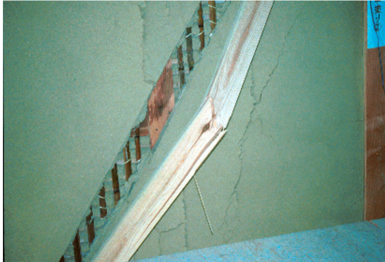
写真 19 試験体 No.7b: 筋かいが座屈により折れる
