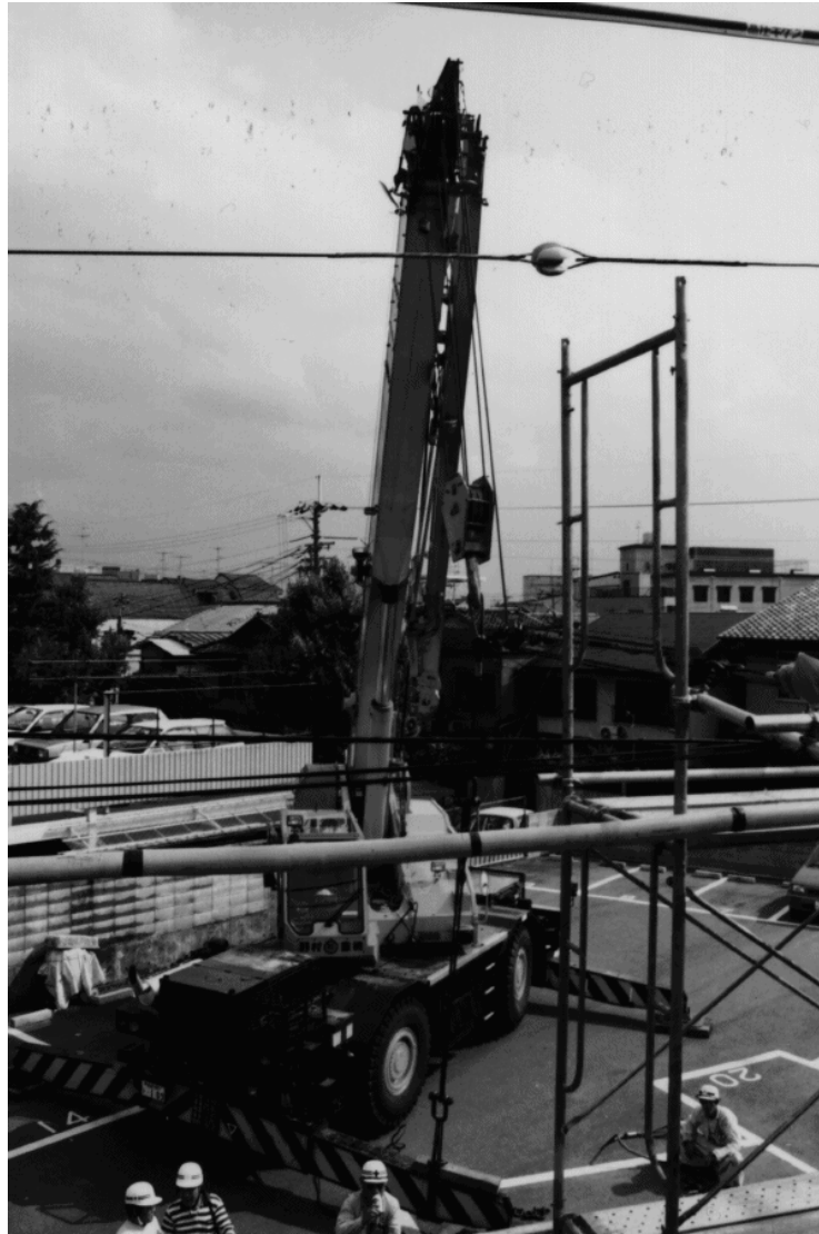
写真 1 荷役に使用したトラッククレーン
