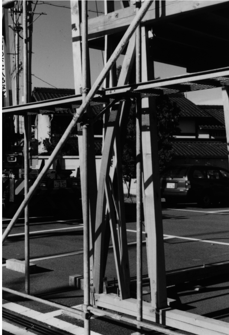
写真 14 H 棟 : step105 で間柱が折れた
